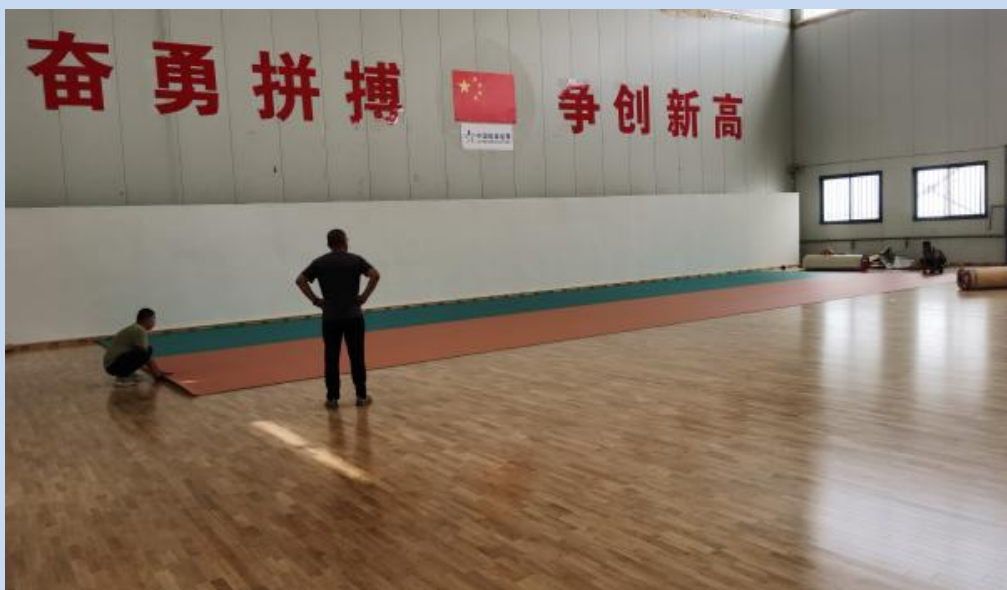
图 6.5.3 完成男子排球馆 PVC 地胶铺设工程
